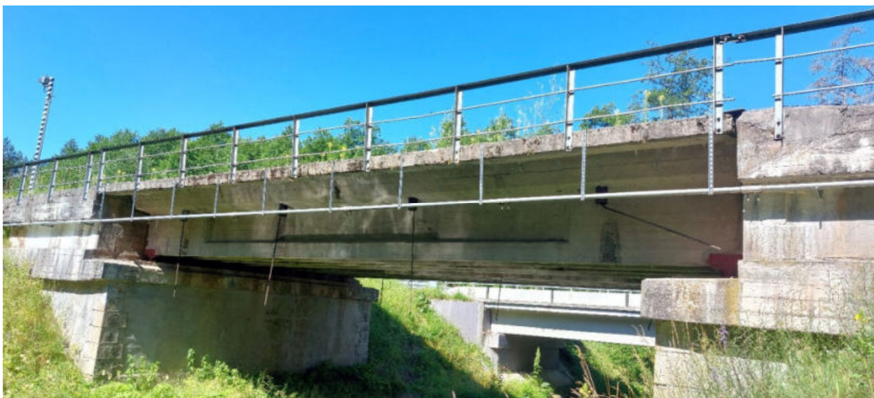
2 pav. Tiltu kelyje N. Vilnia – Turmantas 50+387 km fasadinis vaizdas
