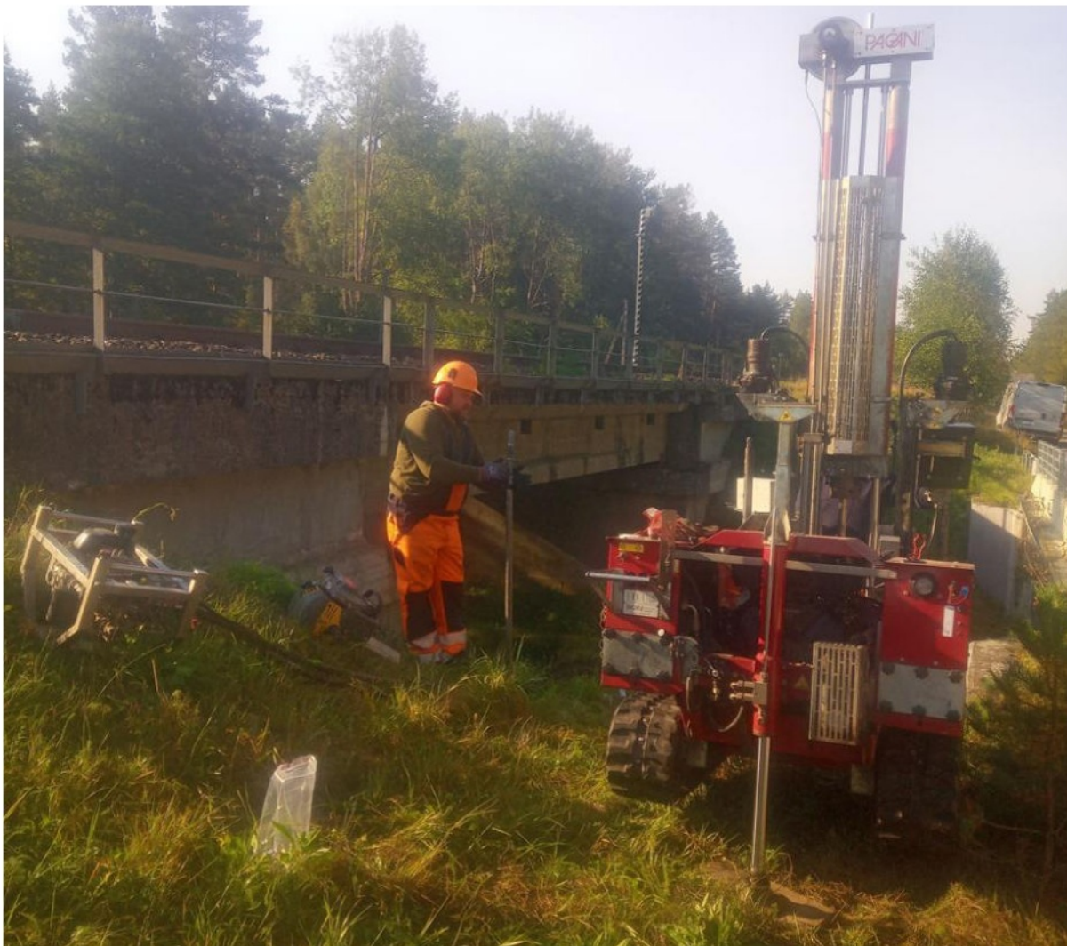
1 pav. Lauko darbai (Gr.SZ/DZ-2).
