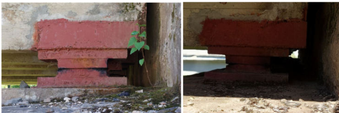
10 pav. Atraminių guolių paviršiai sukorodavę
