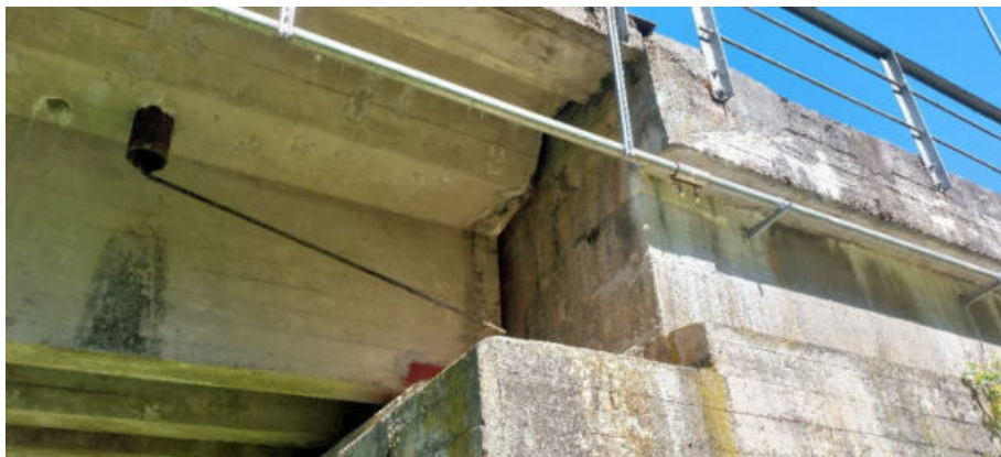
9 pav. Sijos yra pasidengusios apnašomis ties šulinėliais, nuolat drėkinamos, vietomis atšokęs apsauginis sluoksnis, matosi išlindusi armatūra, vietomis ties atramomis atsivėrę plyšiai
