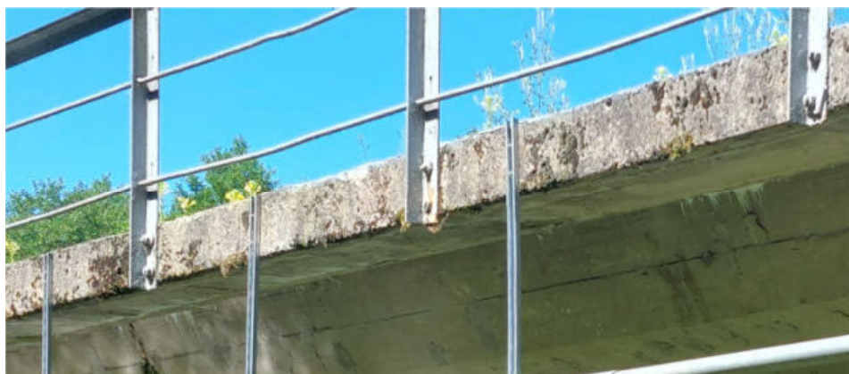
4 pav. Šaltilčių betono paviršius apsamojėjęs, nutrupėjęs betonas
