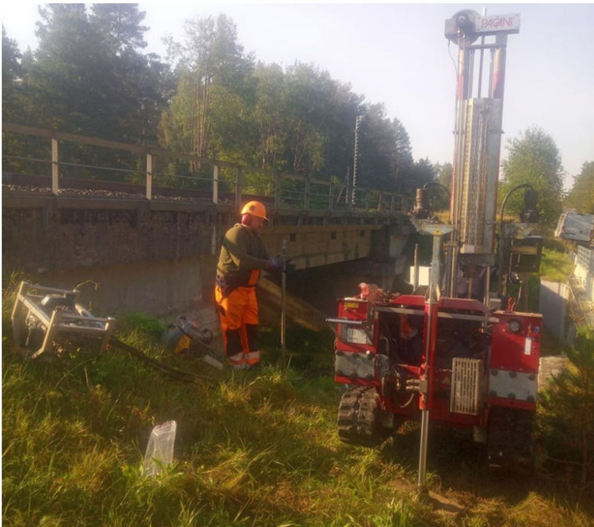
1 pav. Lauko darbai (Gr.SZ/DZ-2).
